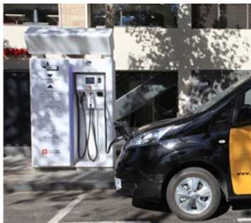
写真-5 電動自動車用充電器
