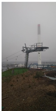
図-6 屋上に設置されたリフト
