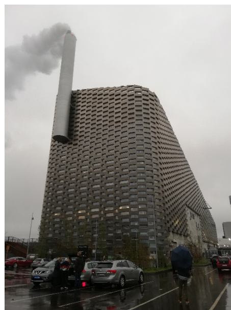
図-4 Amager Bakke 廃棄物発電所
