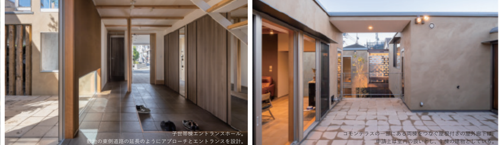
バルコニーが広く、1階全面にわたって関東ローム土ブロック（黒土）を敷き、床下まで暖気を蓄えているのが外平気な印象です。また床とテラスが一体化し、両棟は一体の構造として取っています。
