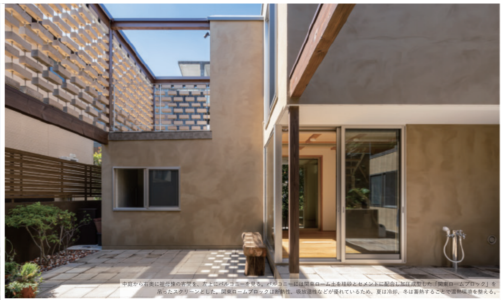
中庭から右側に奥の扉を開くと、中庭の一角が見える。この一角は関東ローム土を珪砂とセメントに配合し加工成型した「関東ロームブロック」を用いたスクリーンとした。関東ロームブロックは断熱性、吸放湿性などが優れているため、夏は冷却、冬は蓄熱することで冷暖房を節減する。
