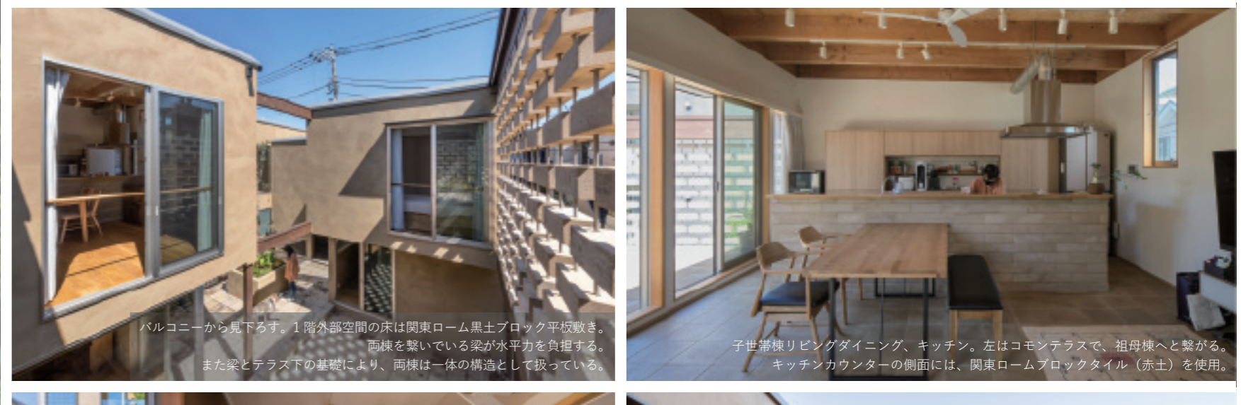
中庭から右側に奥の扉を開くと、中庭の一角が見える。この一角は関東ローム土を珪砂とセメントに配合し加工成型した「関東ロームブロック」を用いたスクリーンとした。関東ロームブロックは断熱性、吸放湿性などが優れているため、夏は冷却、冬は蓄熱することで冷暖房を節減する。
