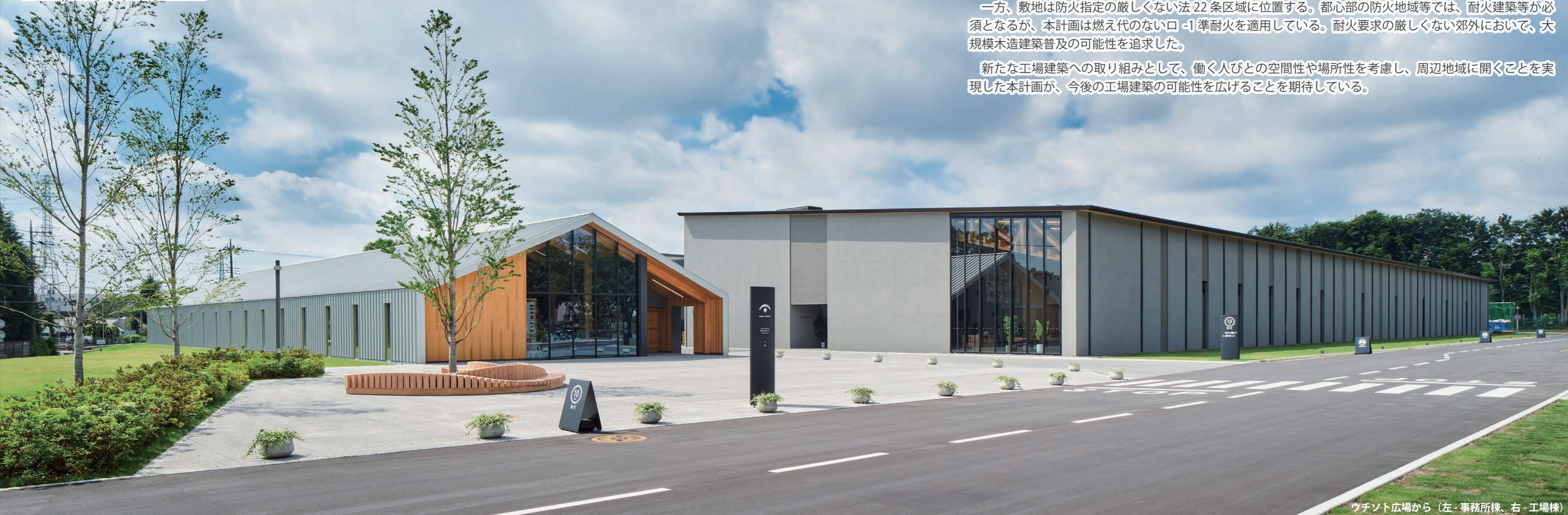
ウチノ森広場から(左-事務所棟、右-工場棟)
