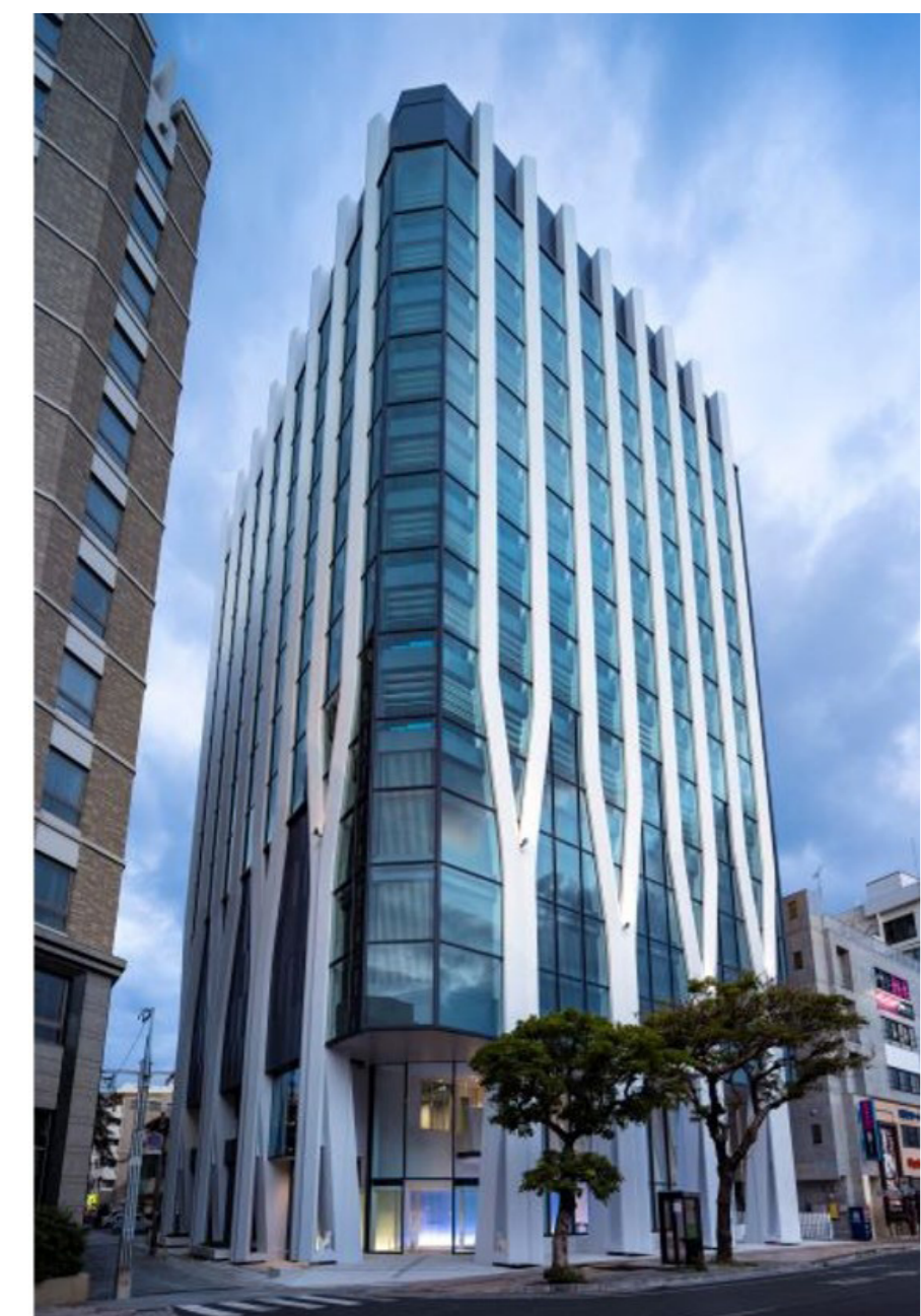
システム導入施設例：沖縄セルラーフォレストビル 延床面積：8,002.84㎡ 階数：地上13階 地下1階 建築主：沖縄セルラー電話株式会社
