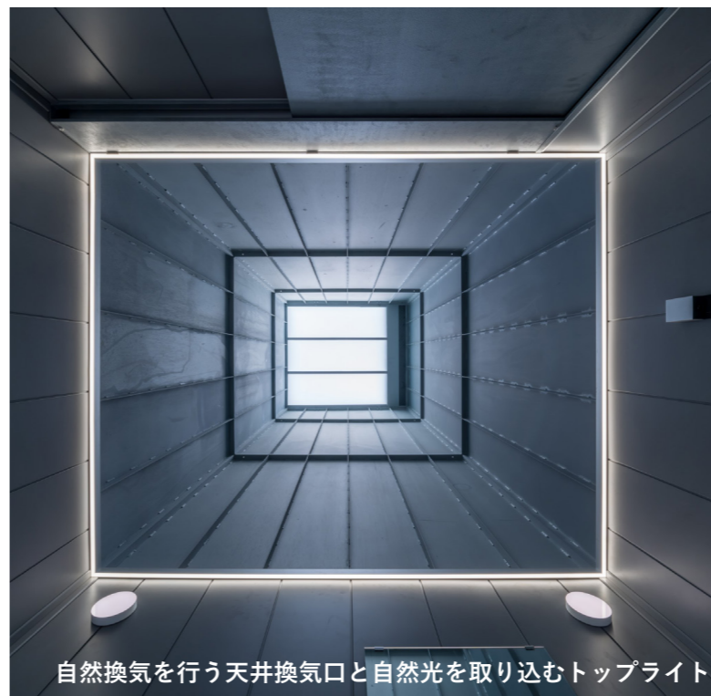
自然換気を行う天井換気口と自然光を取り込むトップライト
