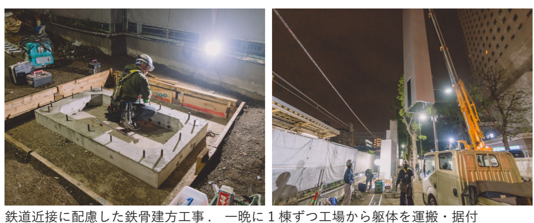
鉄道近接に配慮した鉄骨建方工事。一晩に1棟ずつ工場から躯体を運搬・据付
