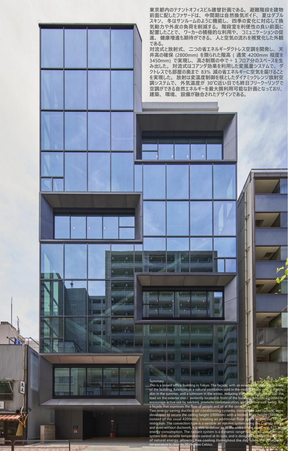
東京都内のテナントオフィスビル建替計画である。避難階段を建物前面に配したファサードは、中間期は自然換気ボディスキン、冬はサンルームのように機能し、四季の変化に対応して換気動力や外皮の負荷を削減する。階段室を利便性の良い前面に配置したこと、ワーカーの積極的な利用や、コミュニケーションの促進、健康増進も期待ができる。人と空気の流れを視覚化した外観である。
