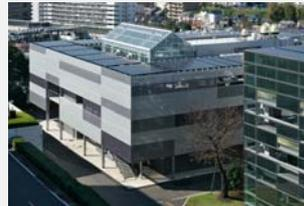
隣接するZEB実証棟と同様の交換可能なファサードをコンセプトに計画
