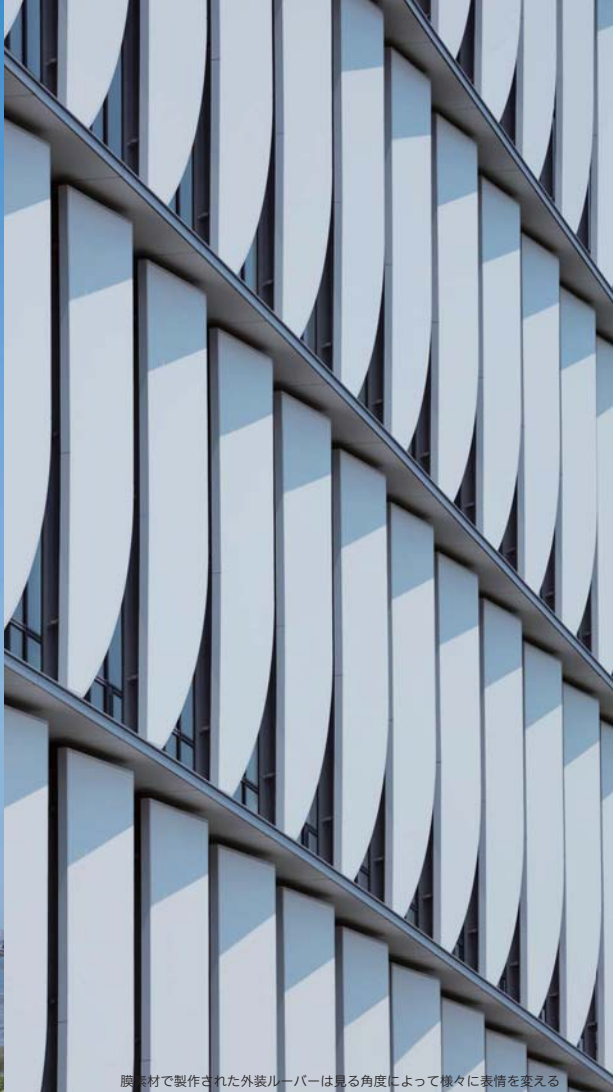
膜材で製作された外装ルーバーは見る角度によって様々な表情を変える
