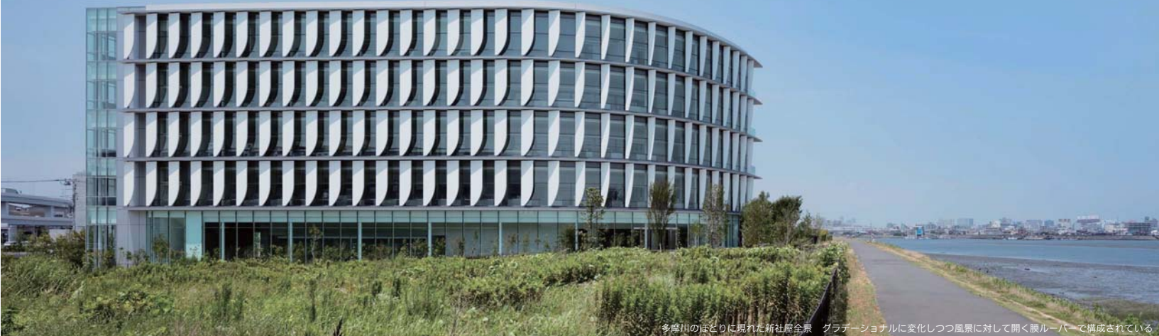
多摩川のはとりに現れた新社屋全景 グラデーションルに変化した風景に対して開く膜ルーバーで構成されている
