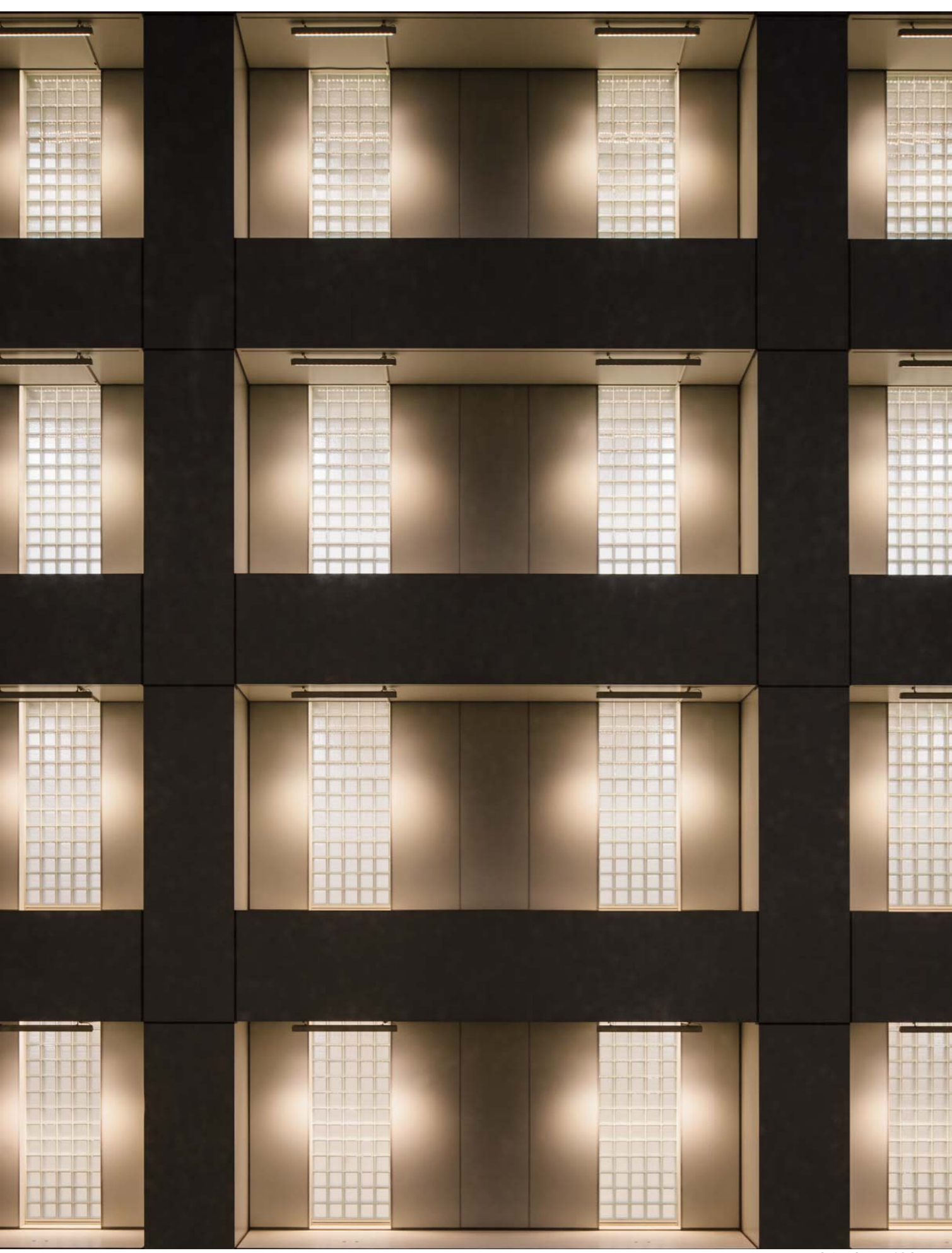
東側壁面の外部照明
