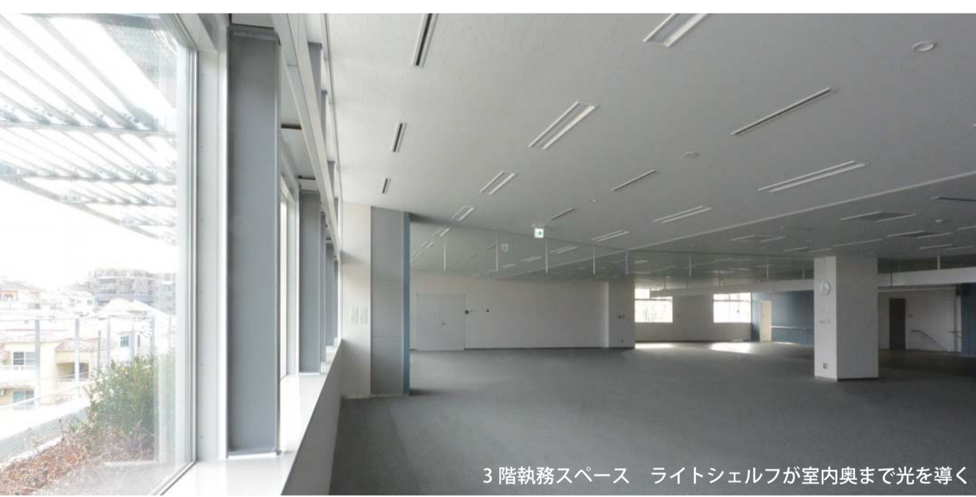
3階執務スペース ライトシェルフが室内奥まで光を導く
