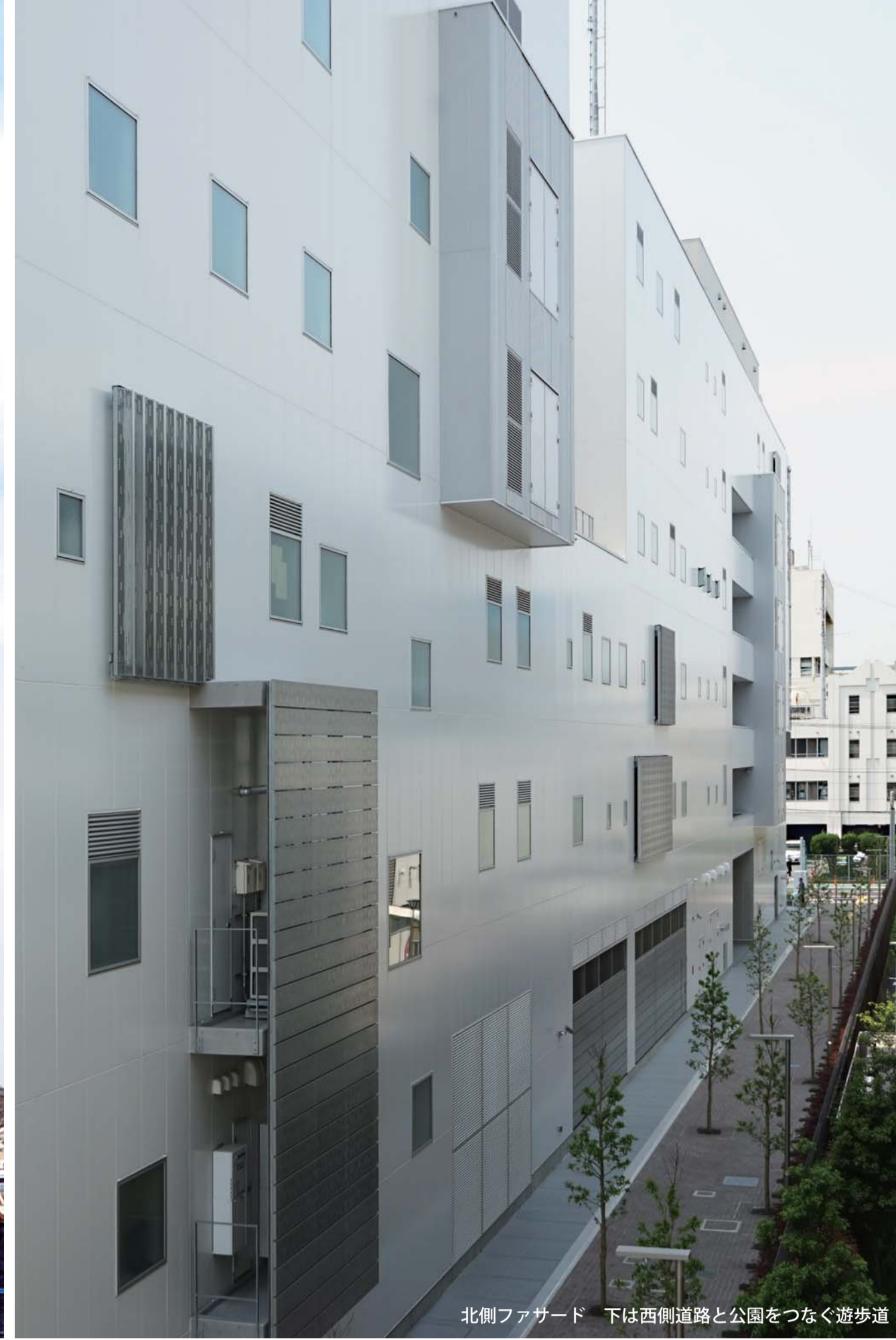
北側ファサード 下は西側道路と公園をつなぐ遊歩道
