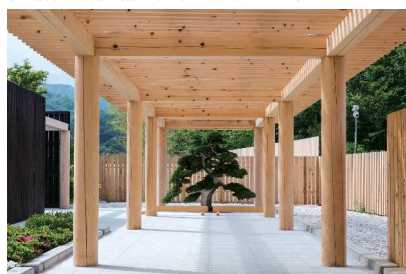
柱の列柱と仕立て樹木により「和」を感じさせる空間を構成。床には300mm角の覆工プレートを使用し、サミット終了後現場でリユース。
