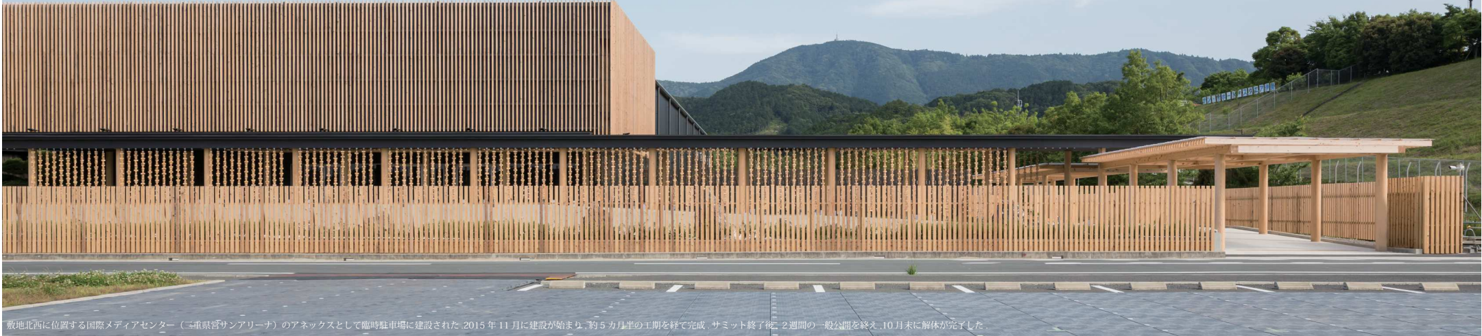
敷地北西に位置する国際メディアセンター（三重県桑名アンアリーナ）のアネックスとして臨時駐車場に建設された。2015年11月に建設が始まり、約5カ月半の工期を経て完成。サミット終了後、2週間の一般公開を終え、10月末に解体が完了した。
