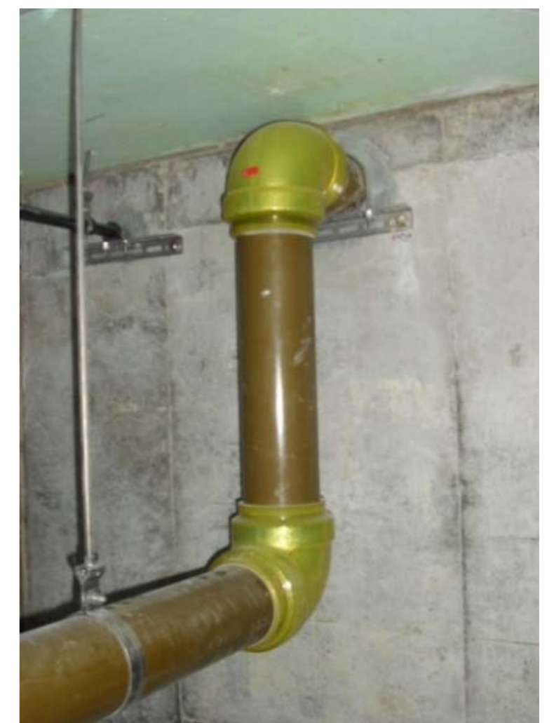
【連結送水管ピット内配管例】
