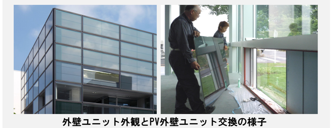
外壁ユニット外観とPV外壁ユニット交換の様子
