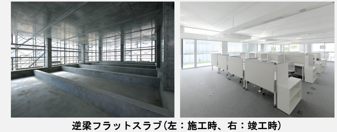
逆梁フラットスラブ(左:施工時、右:竣工時)
