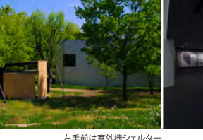
左手前は室外機シェルター
