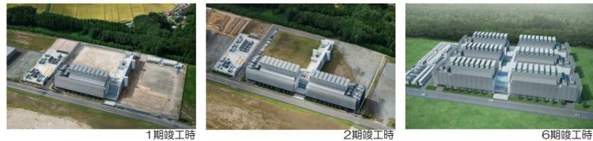
外気の高度利用を行うため、CFDシミュレーションにて、空気取入れ部での適切な風速、温度が維持できるように、隣接間隔、チムニーの高さを検証し、最終的に建設される予定の6棟を配置した。
