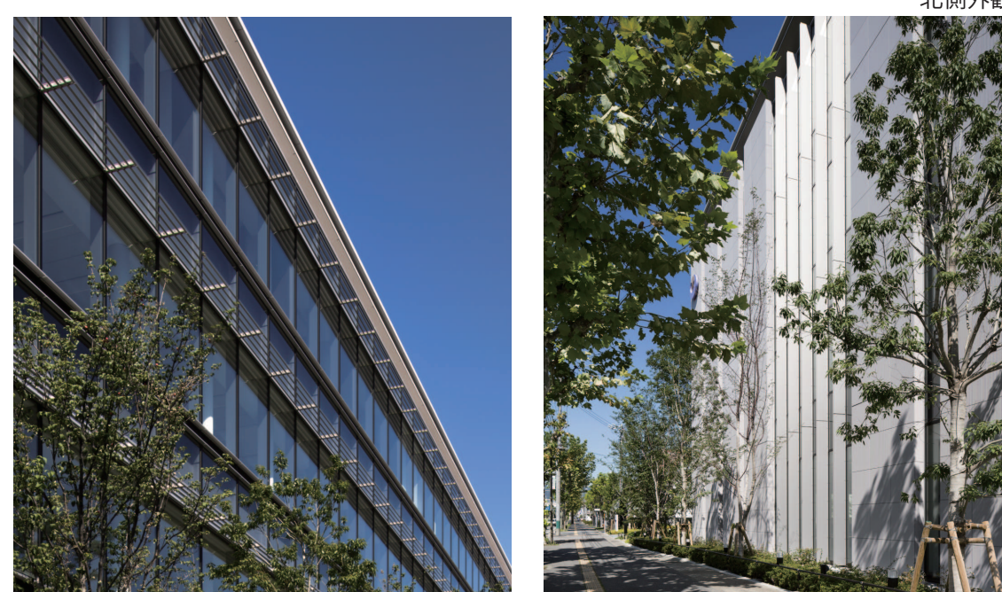
南面（太陽高度の高い日射を防ぐ庇） 東・西面（強い日射を防ぐ壁面）
