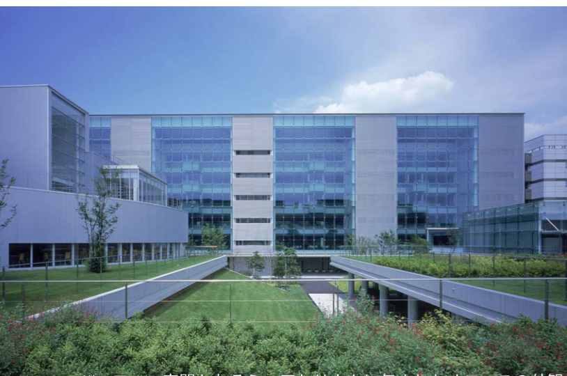
バッファースペースとなるミニアトリウムに包まれたオフィスの外観
