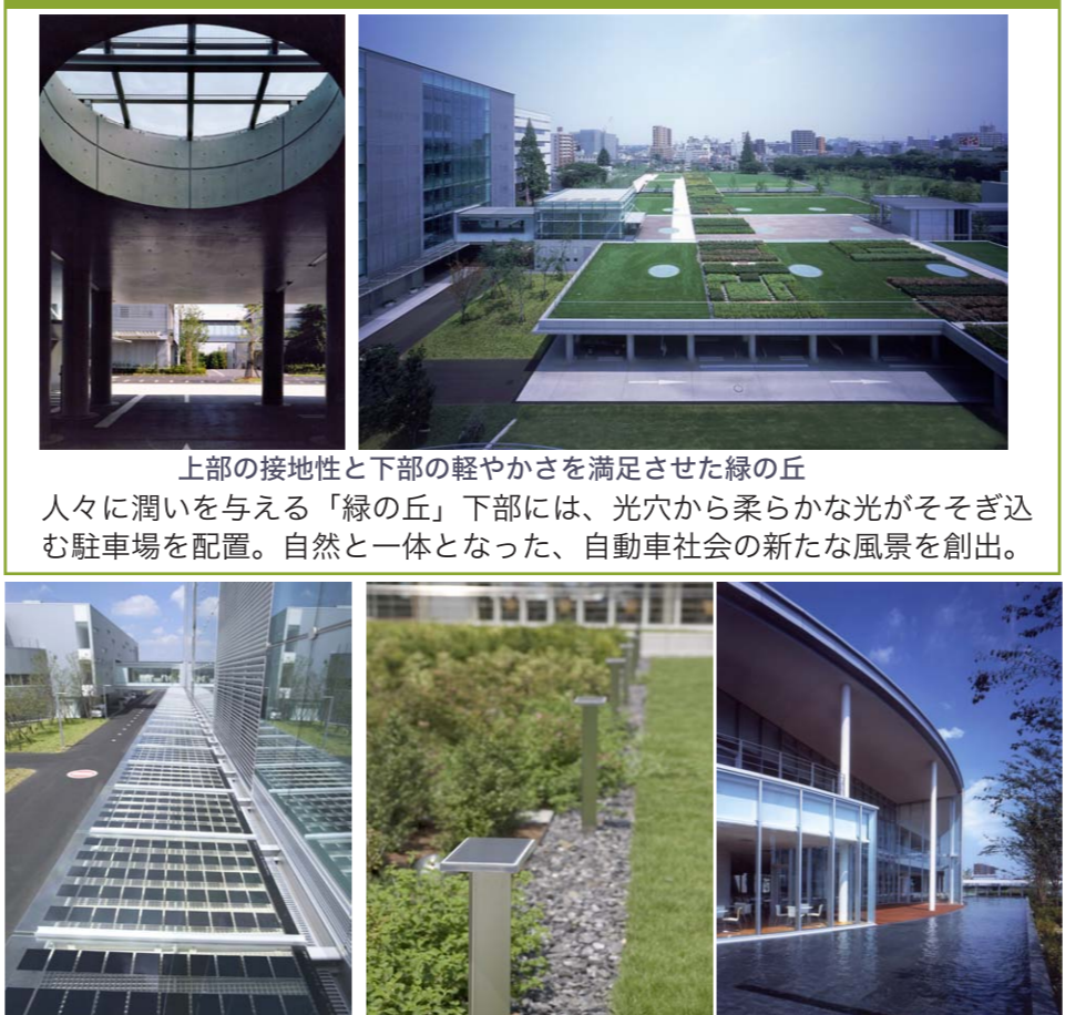
緑の丘を構成する環境装置（例） Hondaが開発したPVセルを利用したガラス庇（写真左）とLED庭園灯（写真中）。丘の上にある水盤（写真右）。
