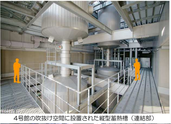
4号館の吹抜け空間に設置された縦型蓄熱槽（連結部）
