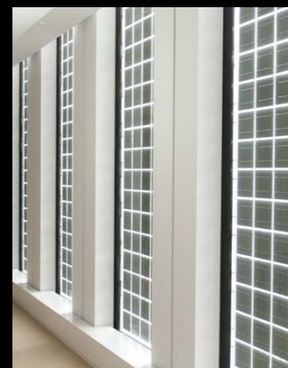
太陽光パネル
