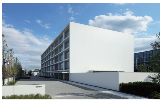
耐震性を確保する妻壁
