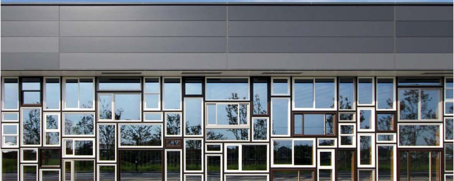
埼玉工場は、首都圏における窓事業の拠点として、物流の要となる圧巻と東北道の結節点に計画された。ここでは住宅用高機能窓（2011年グッドデザイン賞受賞・YKK APブランド窓APWシリーズ）として、樹脂枠と断熱複層ガラスが一体化した製品が作り出される。その工場ファサードには、約300枚の樹脂窓を組み合わせたジュシカーテンウォールを構築し、1つの窓だけでは表現し切れないYKK AP 固有の世界観＝アイデンティティーを表させた。
