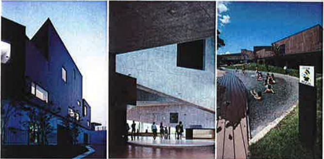
外壁→ブルーのビルドアップ 長尺の断面から見た外壁。樹木の特色に近い藍色の外壁。ササグラスやガラスブロックなど、さまざまな素材を組み合わせ、ランダムな色合いの壁面を演出している。 床→コルク材仕上げ こどもたちが安心して遊べる質実な床。一本一本の木の質感が感じられる。コストを下げつつも、自然素材の良さを出している。 外壁→再生木 周辺の土に近い色の再生木を使用した外壁。一本一本の木の質感が感じられる。コストを下げつつも、自然素材の良さを出している。
